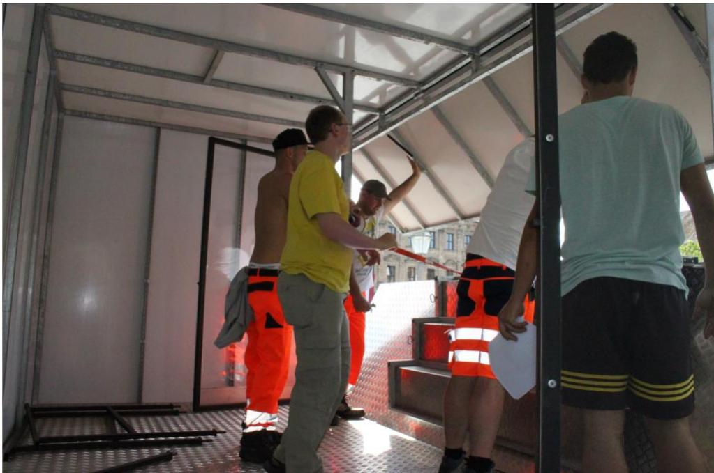
Liegt die Bodenklappe auf den Einschubrohren auf, kann an der Winde im entlasteten Zustand der Hacken ausgehängt werden.
